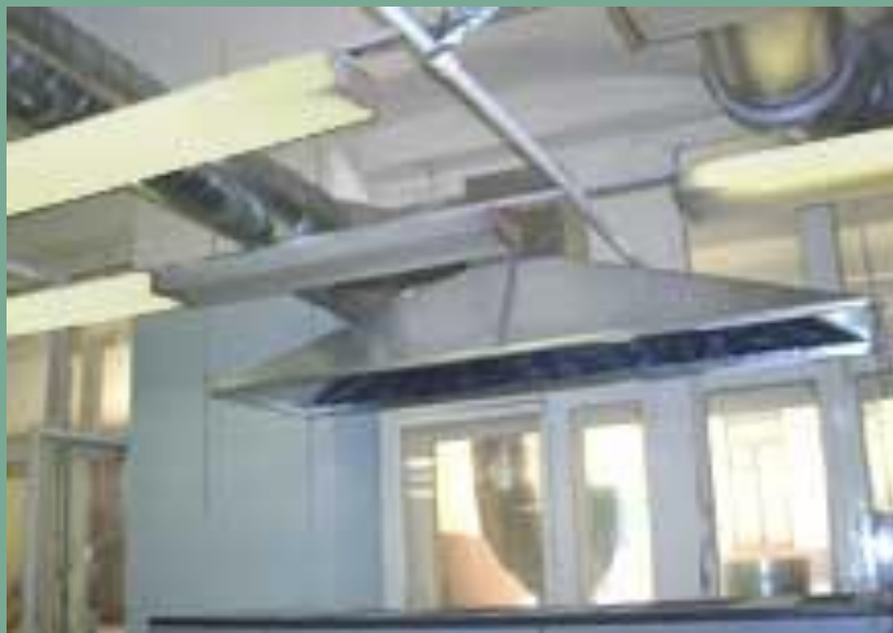
Фиг. 1 Вытяжное локализирующее устройство вентиляции (зонты)
