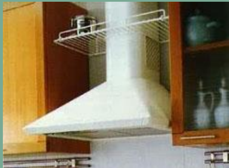
Фиг. 1 Вытяжное локализирующее устройство вентиляции (зонты)
