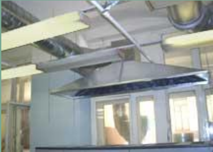
Фиг. 1 Вытяжное локализирующее устройство вентиляции (зонты)
